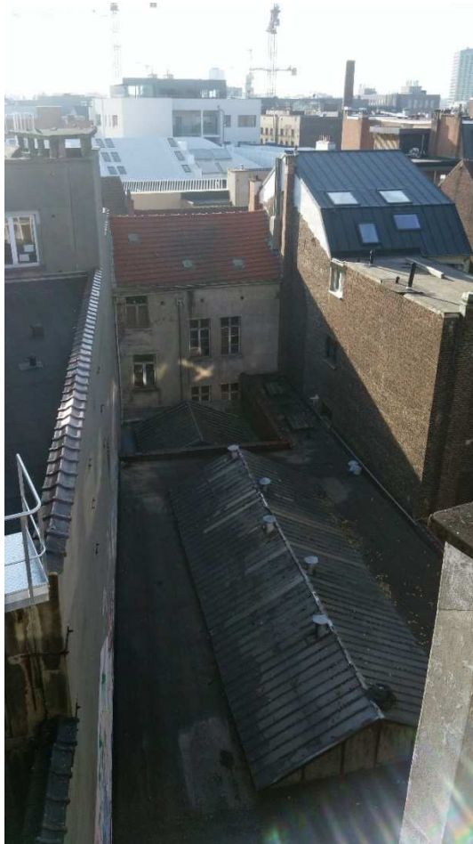
Vue sur la toiture plate au 5è vers la Rue du Berger
